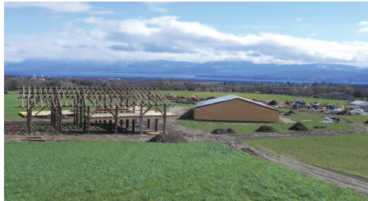
Place de fête de Givrins mars 2024. Construction des bâtiments en bois sur mesure pour l'évènement.
